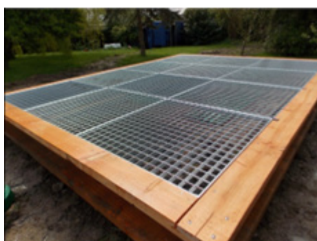
Exemple de grilles de protection sanitaires (avant pousse des roseaux)
