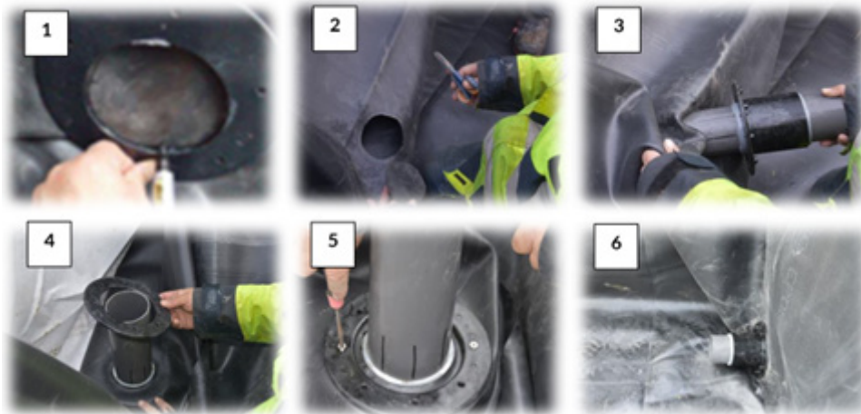
Procédure d'installation de la traversée de paroi
