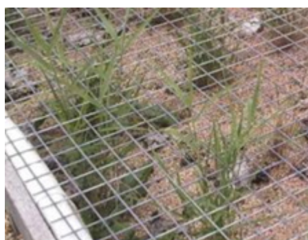
Exemple de grilles de protection sanitaires (avant pousse des roseaux)
